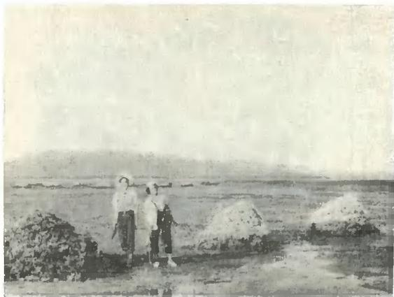
Рис. 7. Кучи кораллов, добытых для обжига на известь
